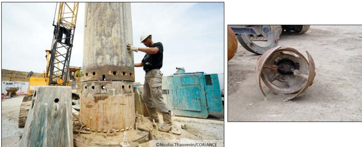
Figure 81 : Mise en place d'un tube guide par louvoisement et vue d'une coquille utilisée pour l'extraction des déblais
