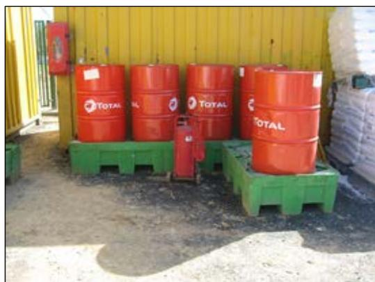
Figure 179 : Bacs de rétention et stockage d'huile sur un chantier
