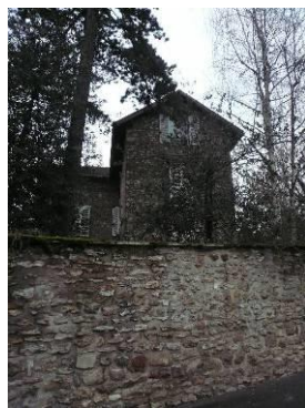
Les murs de pierre dans l'enceinte du centre ancien
