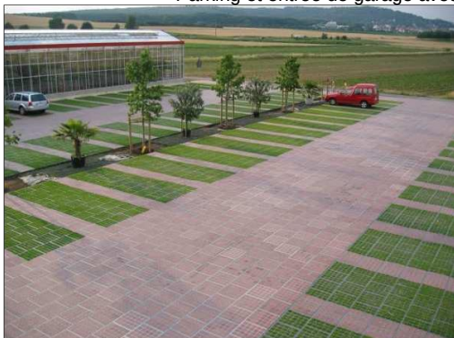
Parking et entrée de garage avec dalles en pavé et en gazon
